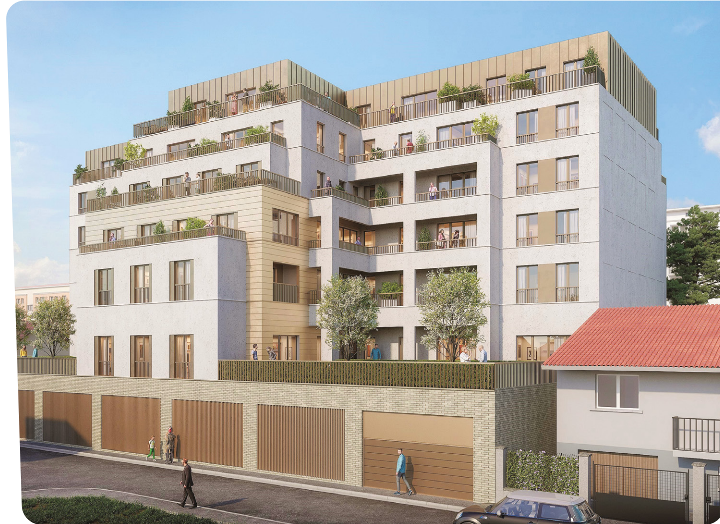
FAÇADE OUEST SUR LA RUE MORIN
